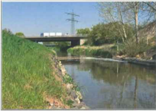
Die Autobahn A61 führt über den Kraichbach.
