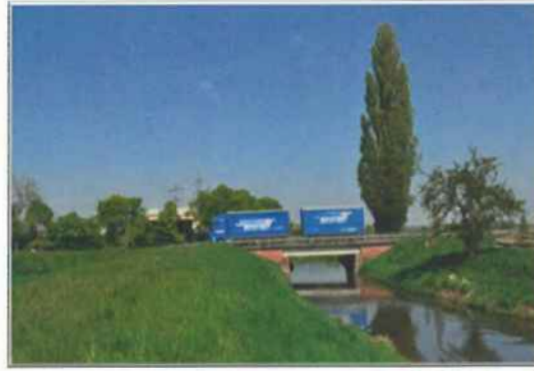
Brücke der Landstraße L 722
